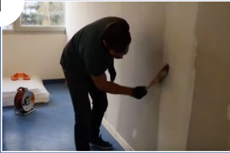
BIEN NETTOYER LA ZONE AVANT LA POSE
