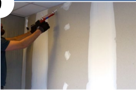
APPLIQUER LA COLLE AU MUR (OU AU PANNEAU)
